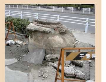
出典：財団法人消防科学総合センター 東日本大震災 液状化により浮き上がったマンホール被害の様子
